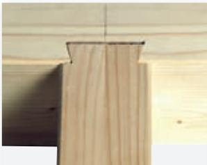
Für Schwalbenschwanz-Verbindungen an Tragbalken oder Sparren.
