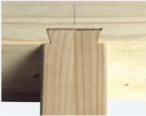
Für Schwalbenschwanz-Verbindungen an Tragbalken oder Sparren.
